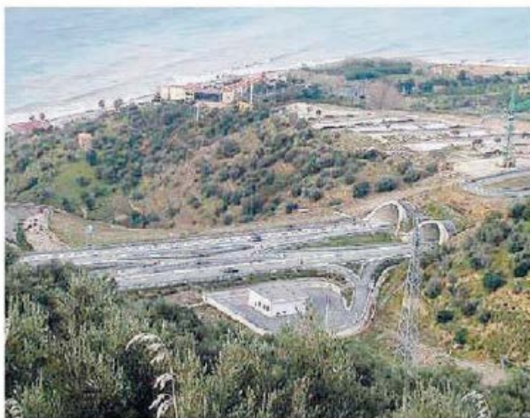
La A20 nei pressi di Tusa. Il manto stradale in alcuni tratti è dissestato
